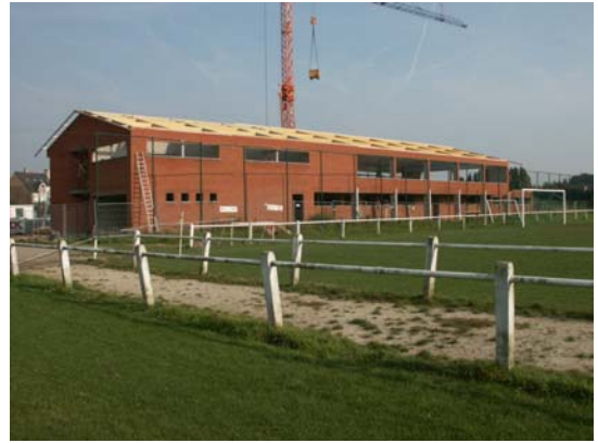
september 2005: plaatsen dak
